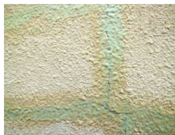
GC-500にて亀裂補修
