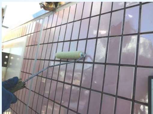
鏡面タイル面 GC-500施工
