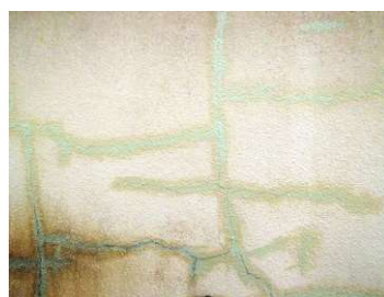
GC-500にて亀裂補修
