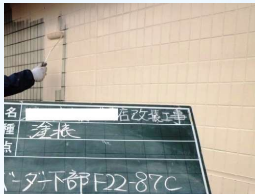
GC-500施工後色塗装
