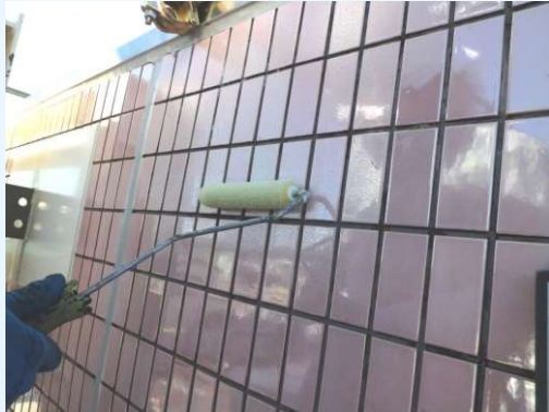
鏡面タイル面 GC-500施工
