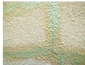
GC-500にて亀裂補修
