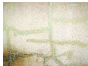
GC-500にて亀裂補修
