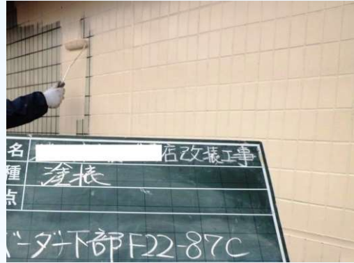
GC-500施工後色塗装
